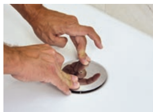
9 Sifonabdeckung einsetzen
