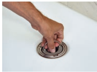
7 Sifoniereinsatz einsetzen
